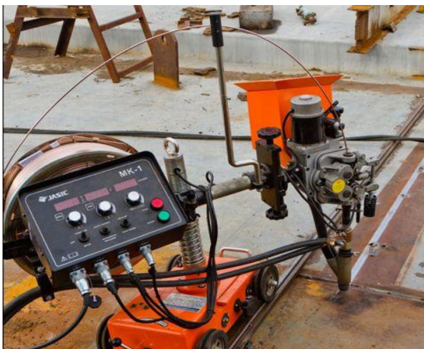
Рисунок 3.2 – Загальний вигляд процесу автоматичного дугового зварювання під шаром флюсу
