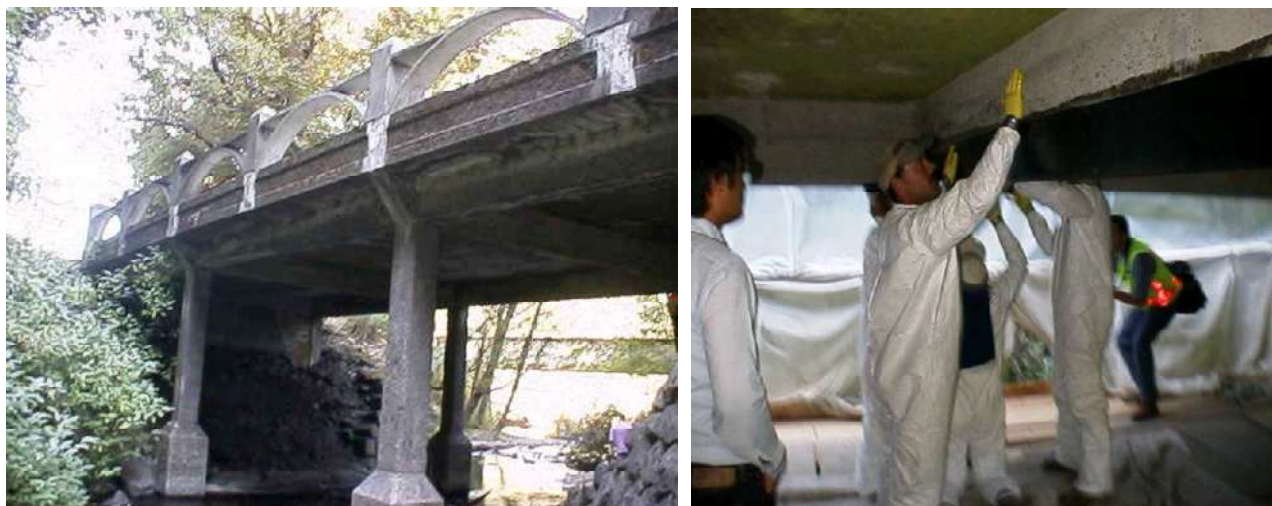
Рисунок 3.1 – Підсилення конструкції моста «Horsetail Creek Bridge», США (Орегон) вуглепластиковим композитним волокном
