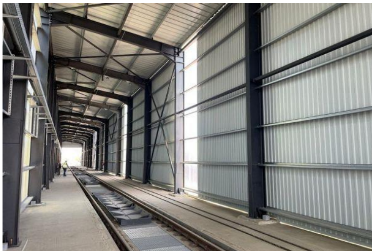
Рисунок 1.2 - Накриття станції розвантаження залізничних вагонів
