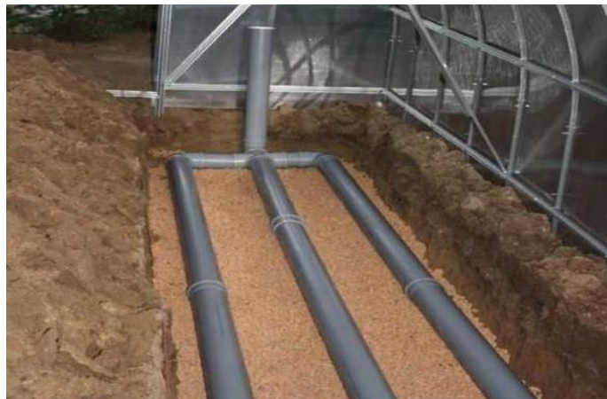
Рисунок 3.3 – Метод підігріву теплиці теплим повітрям
