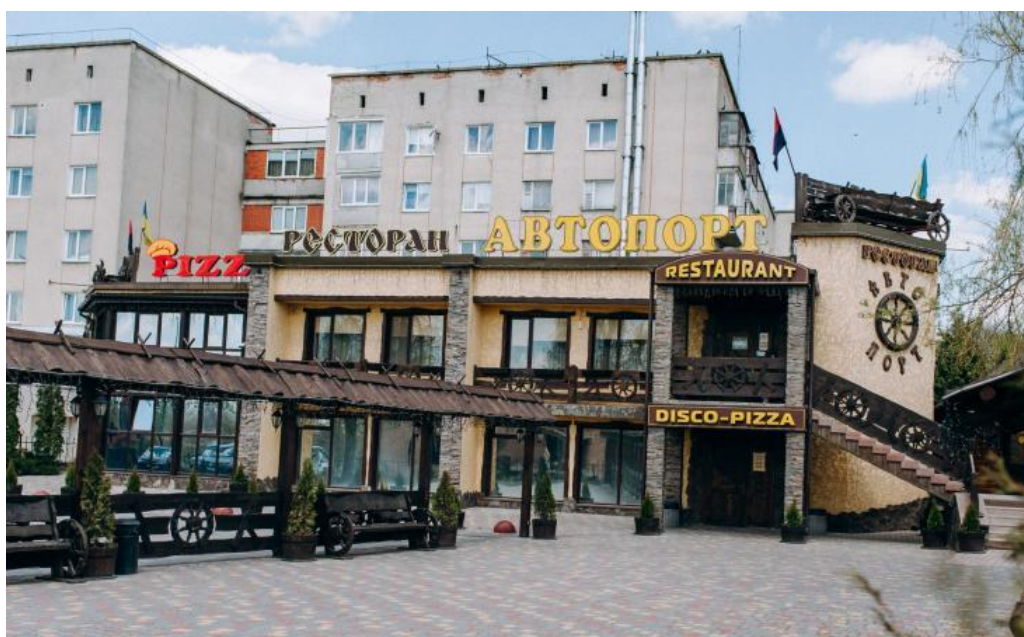
Рис. 2.1. Зовнішній вигляд ресторану «Автопорт»
