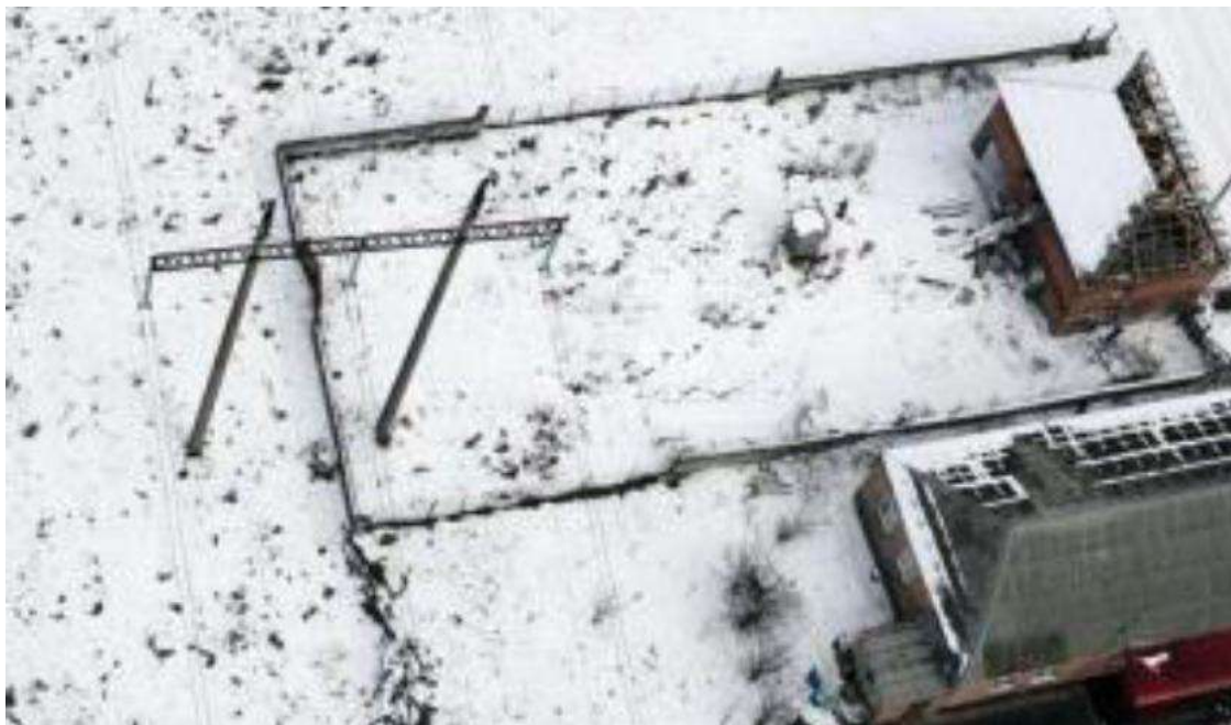
Рисунок 1.10 – Виявлення порушення охоронної зони ЛЕП
