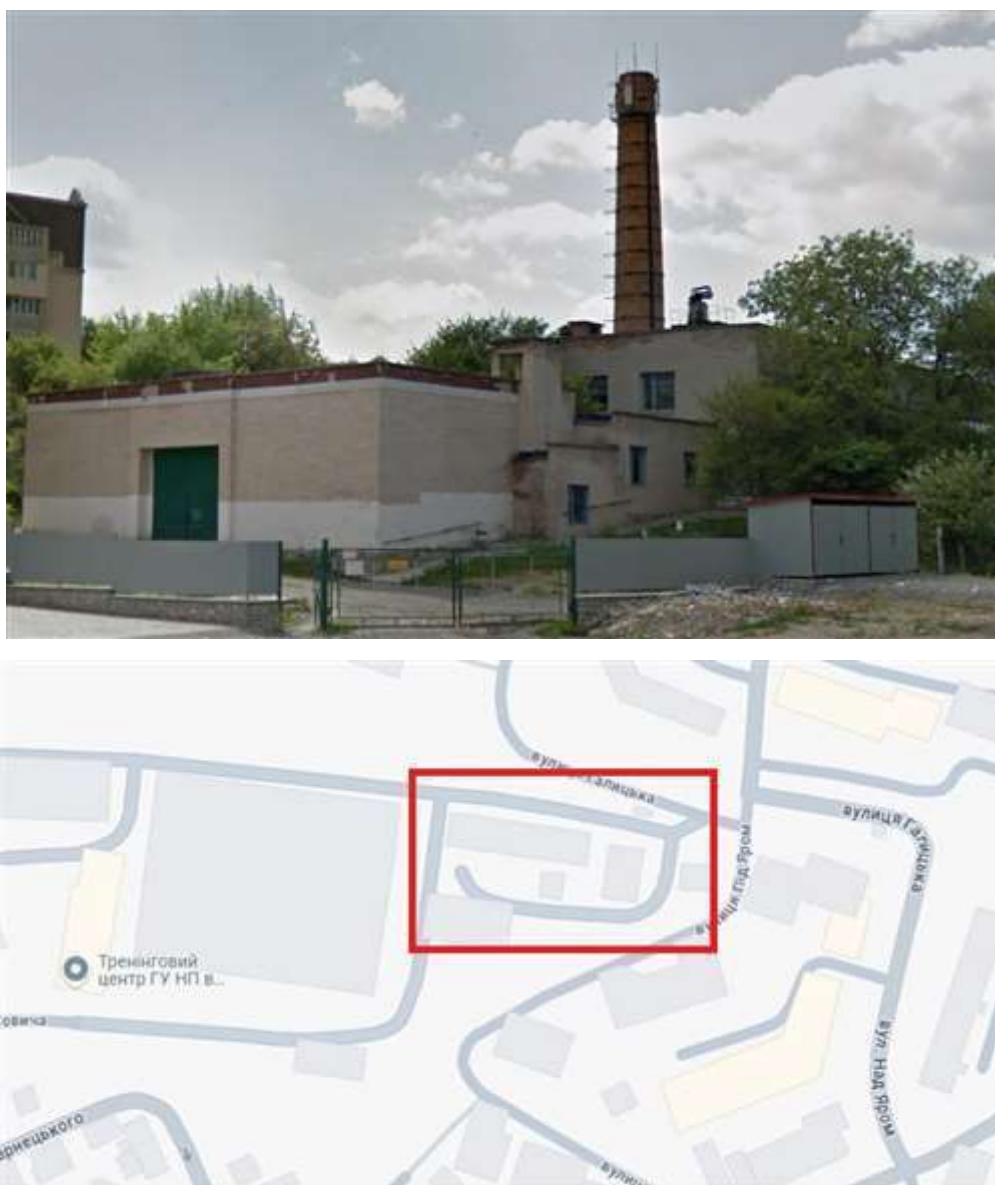
Рисунок 2.1 – Загальний вигляд та розташування котельні Галицька.
