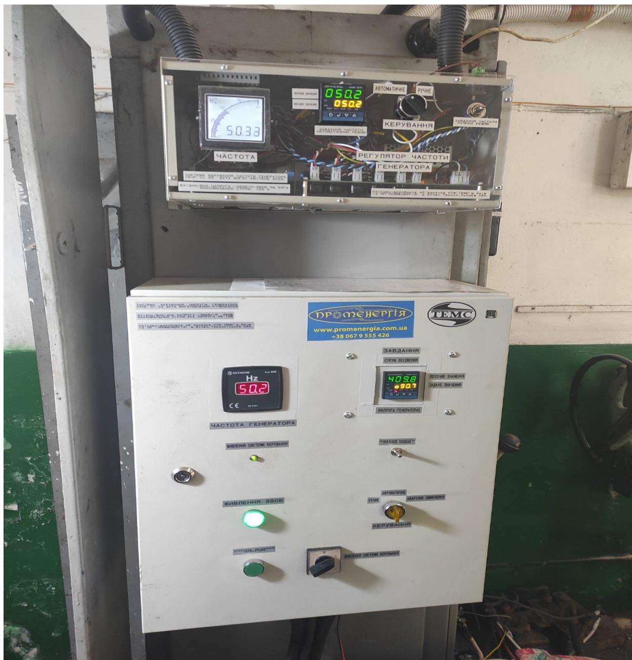
Рисунок 3.2 - Система управління автономною ГЕС
