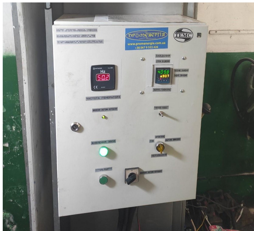
Рисунок 3.5 - Зовнішній вигляд модуля стабілізації напруги генератора
