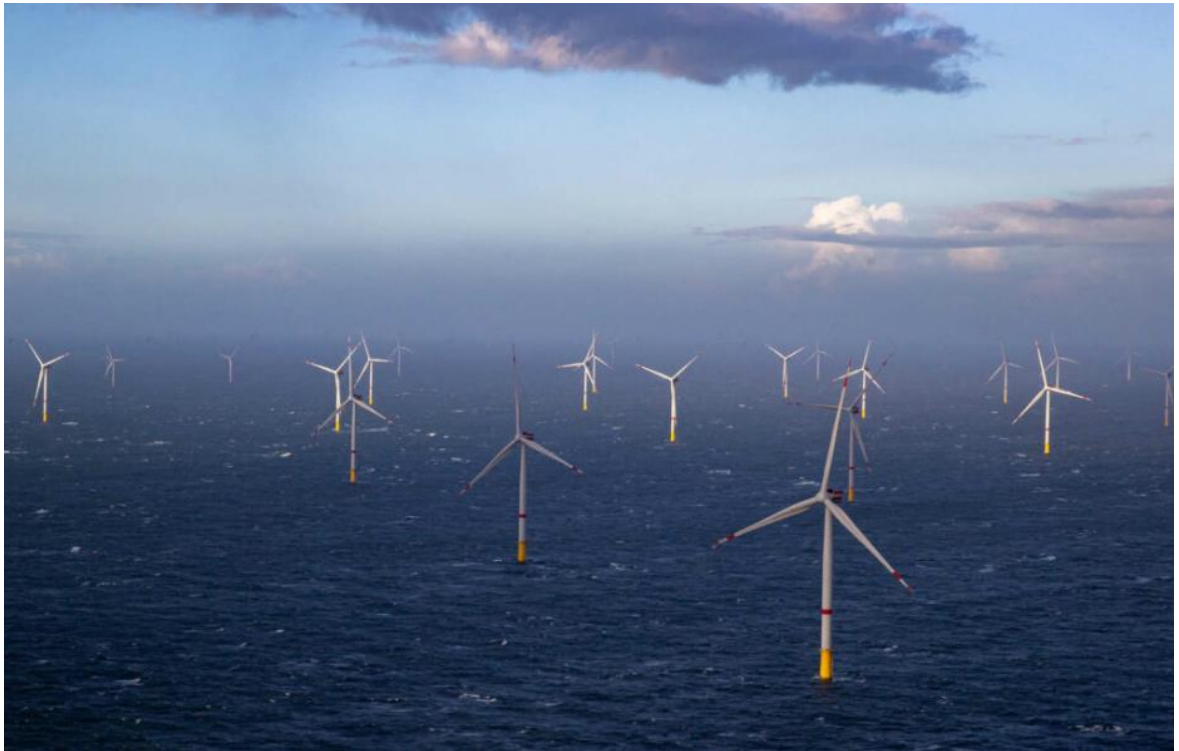
Рисунок 3.8 – Бельгійська морська вітроелектростанція
