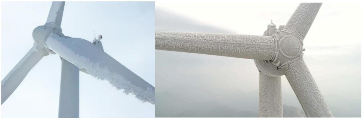
Рисунок 2.8 – Обледеніння на лопатей вітрової турбіни
