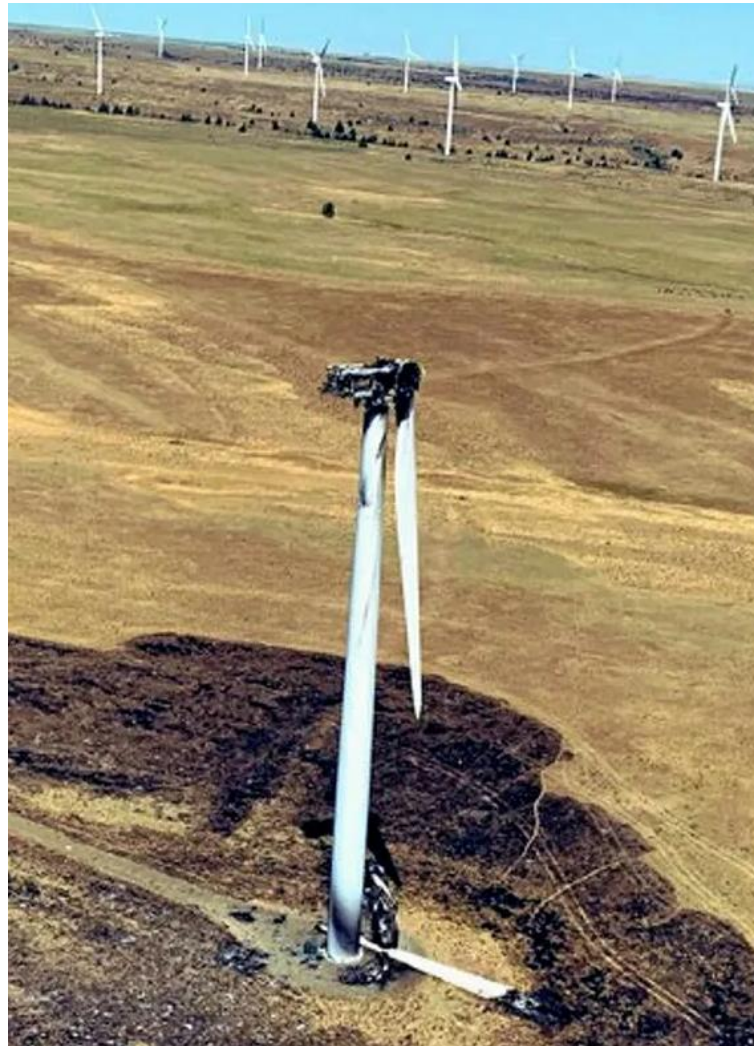
Рисунок 3.1 – Пожежа на вітровій турбіні у США, Вашингтон [16]
