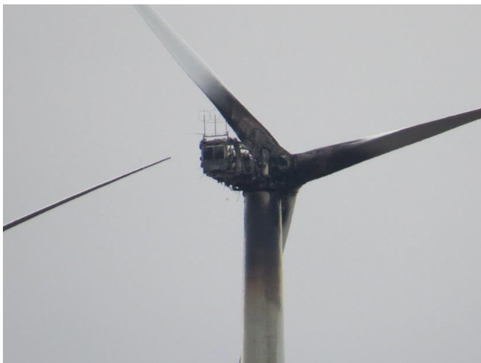
Рисунок 3.3 – Норвегія Пожежа на турбіні Fitjar Midtfjellet Vindkraft
