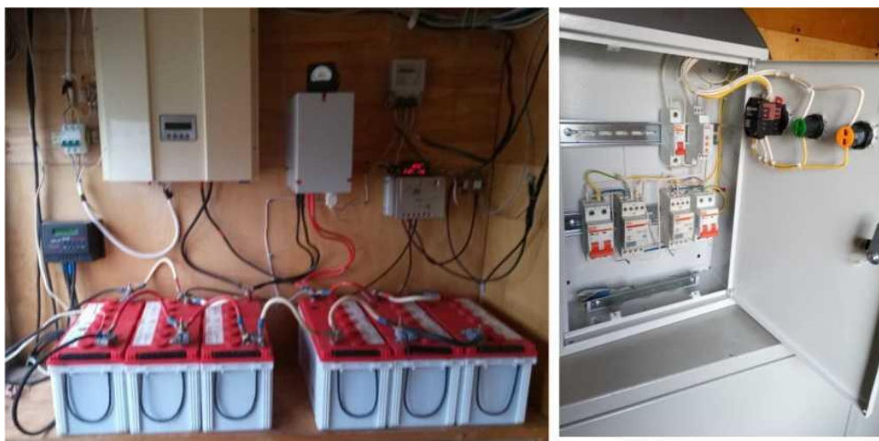
Рисунок 3.9 - Схема перемикання на резервне джерело живлення через АВР: ліворуч - показано АКБ і контролери ВЕУ та ФЕП; праворуч – АВР
