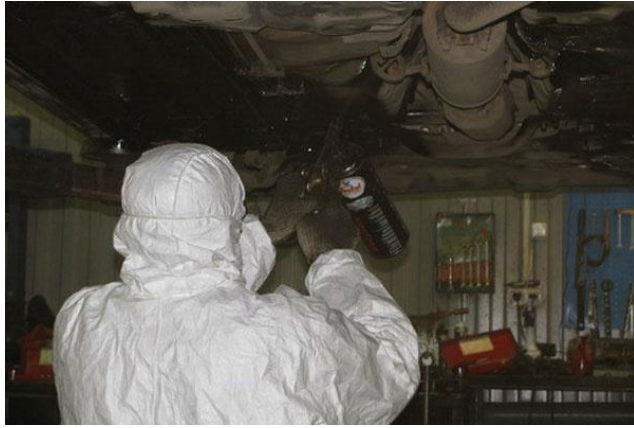
Рисунок 2.4 – Технологія нанесення антикорозійних матеріалів на днище автомобіля
