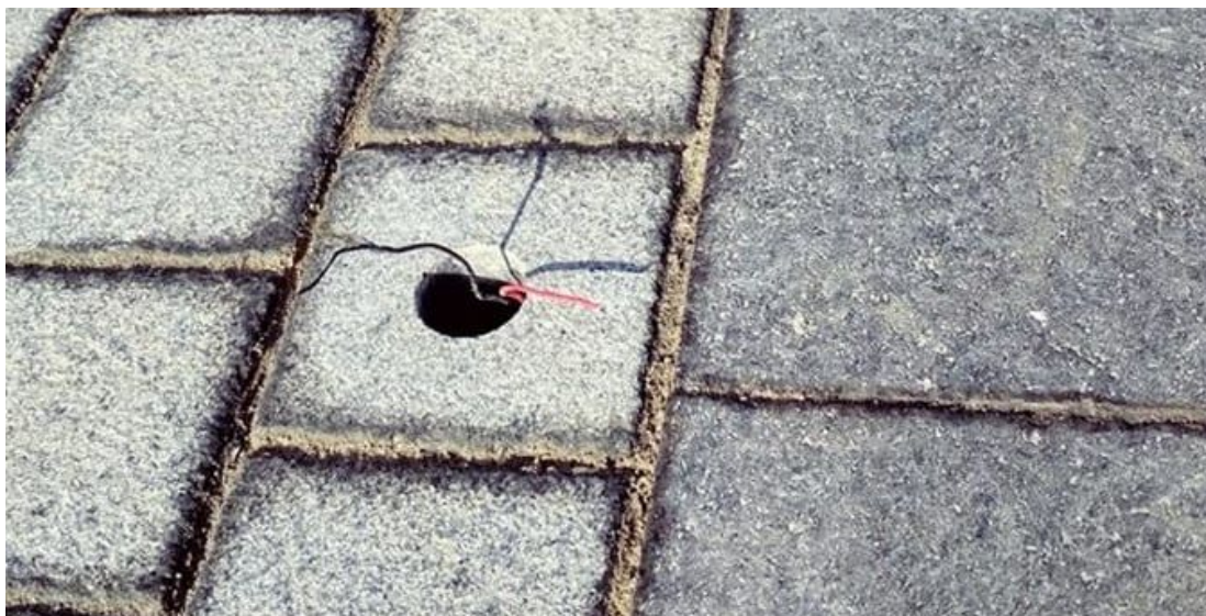
Рисунок 1.3 – Підведення живлення до точкових світильників
