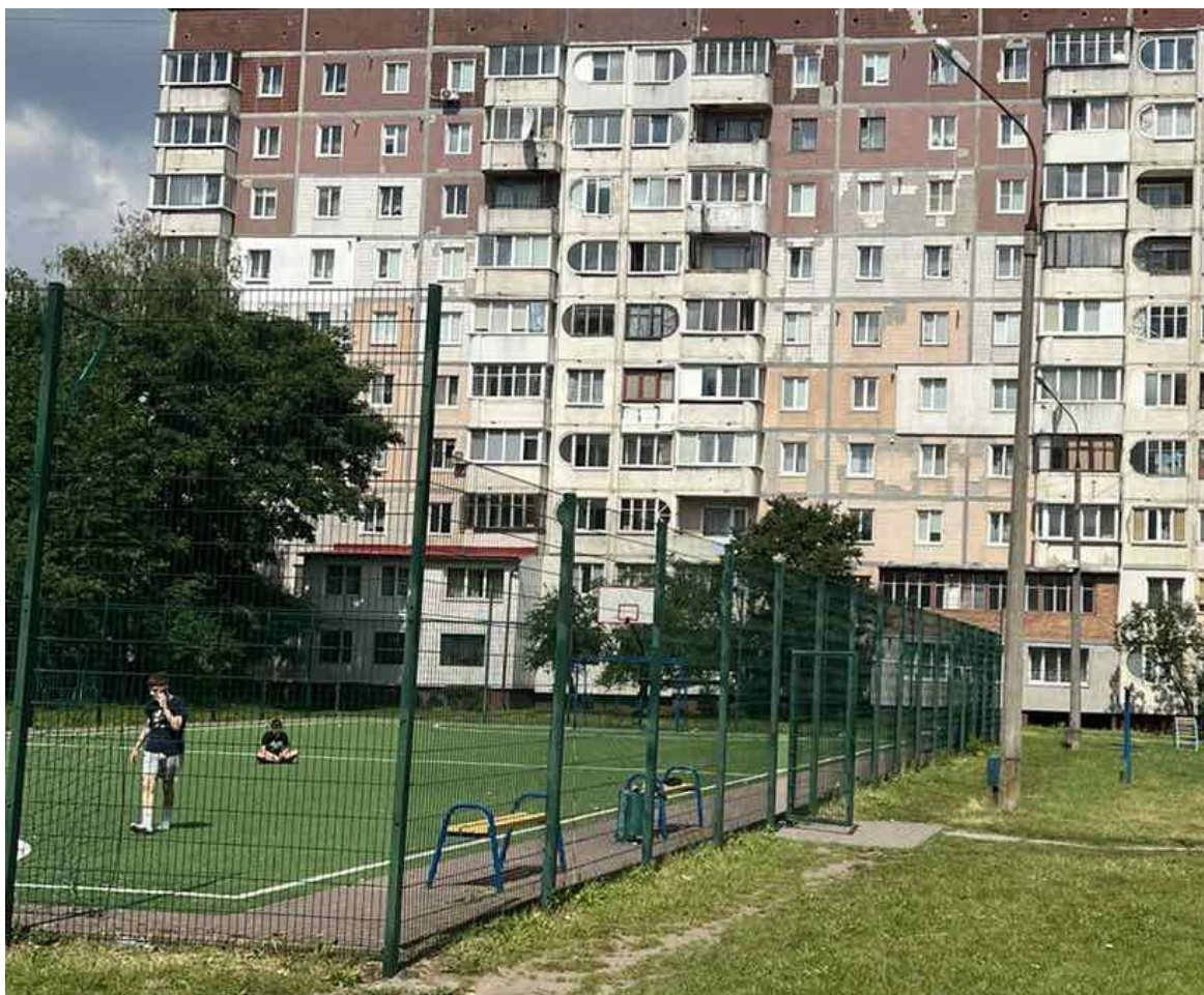
Рисунок 3.1 – Зображення світлових приладів існуючої системи освітлення спортивного майданчика по вул. 15 квітня 35
