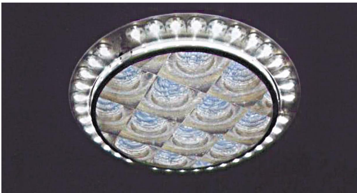
Рисунок 2.13 – Гібридна освітлювальна система LED+«SOLARSPOT»
