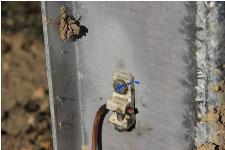
Рисунок 1.2 - Скріплювальні шайби в поєднанні з притискними хомутами та болтовими з'єднаннями
