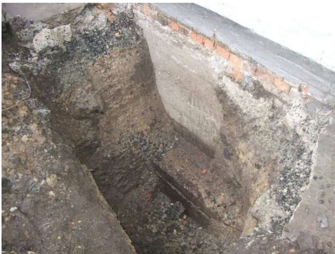
Рисунок 3.21 – Шурф №1 дослідження глибини закладення та ширини підшви фундаменту будівлі
