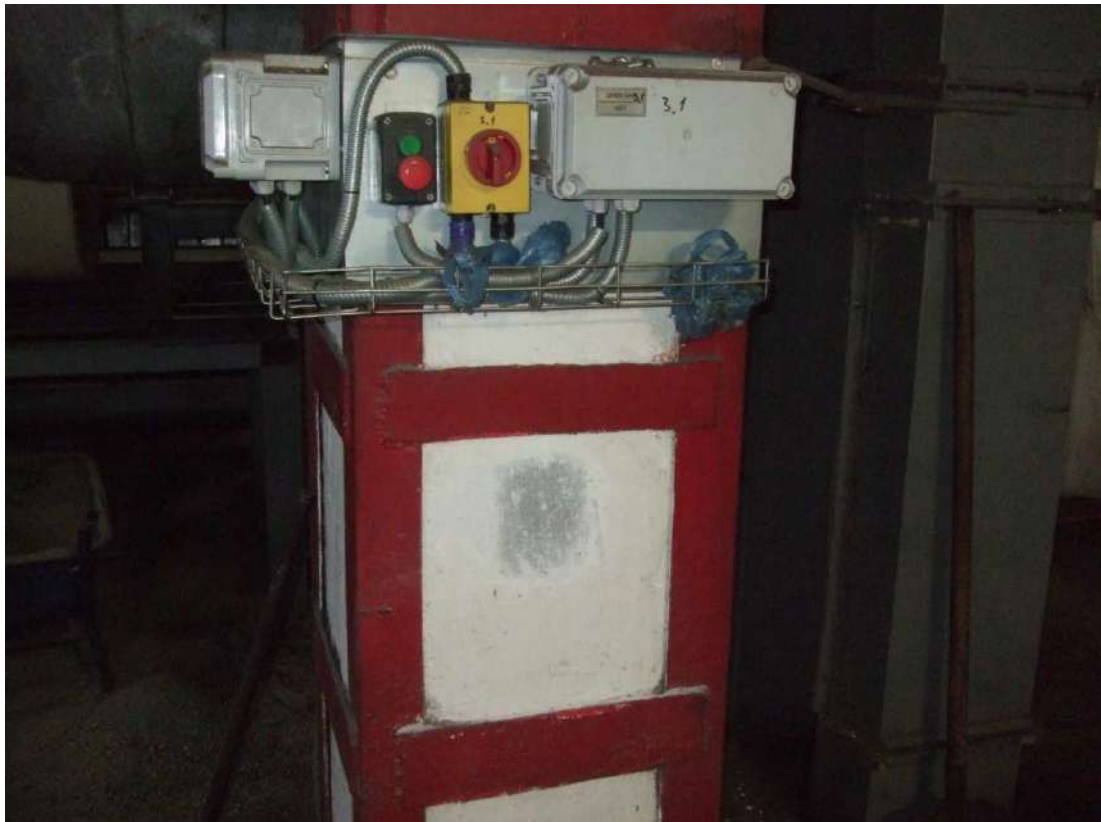
Рисунок 3.19 – Ділянка дослідження міцності бетону монолітної залізобетонної колони 1-го поверху будівлі РВО
