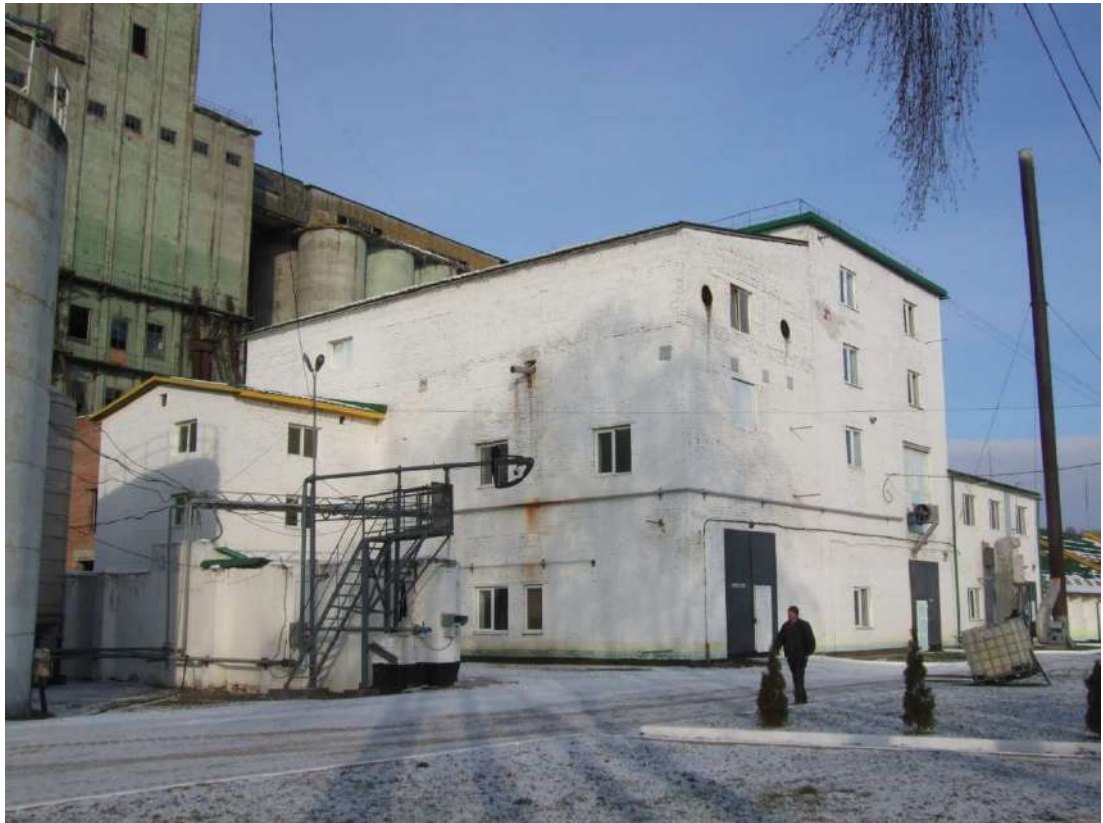
Рисунок 3.16 – Загальний вигляд будівель Цеху по переробці олійних культур, що знаходяться за адресою вул. Котляревського, 8 у м. Волочиськ Хмельницької області
