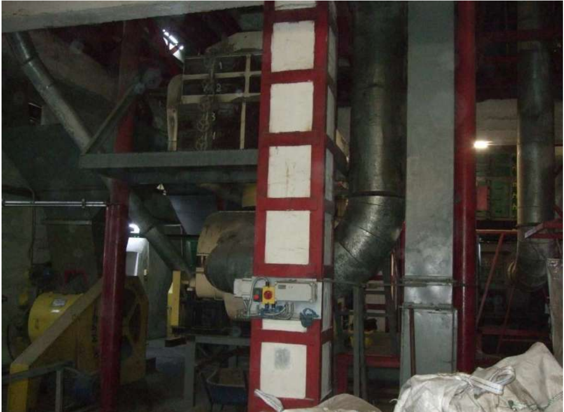
Рисунок 3.18 – Монолітна залізобетонна колона 1-го поверху будівлі РВО, що підлягала інструментальним дослідженням
