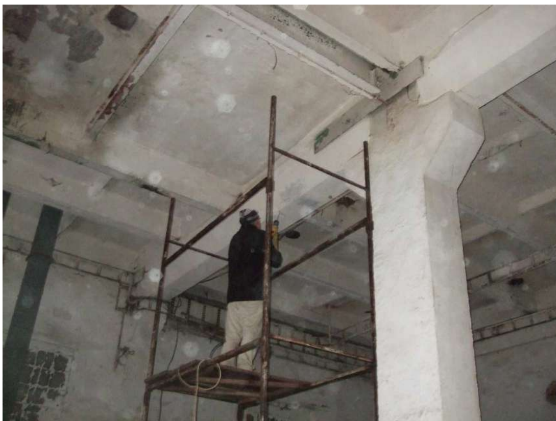
Рисунок 3.15 – Інструментальні дослідження збірного залізобетонного ригеля перекриття 1-го поверху будівлі Круп'яного цеху під літ. «К»
