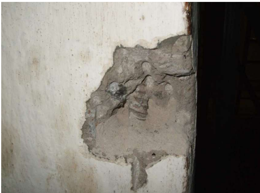
Рисунок 3.20 – Місце визначення параметрів армування монолітної залізобетонної колони 1-го поверху будівлі РВО
