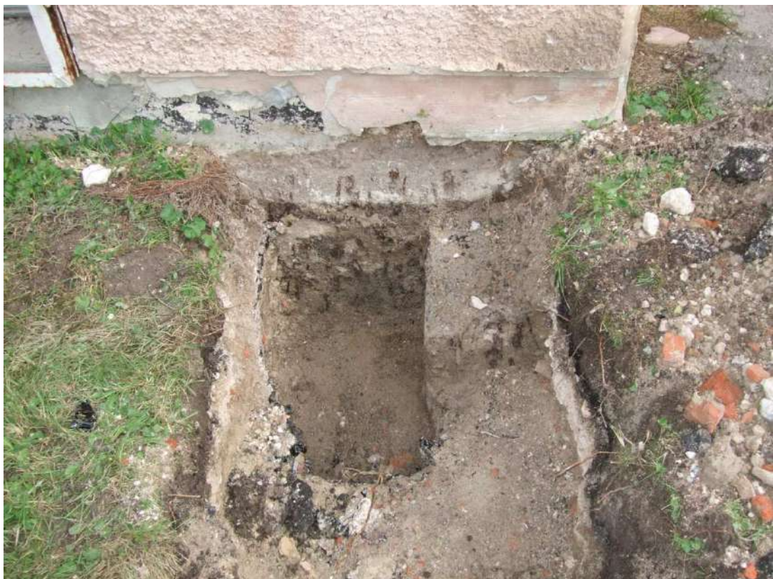
Рисунок 3.6 – Шурф №2 біля фундаменту частини будівлі, що використовується в якості готелю. Місце дослідження фундаментних збірних бетонних блоків
