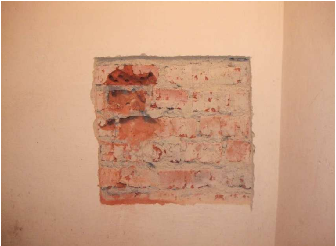
Рисунок 3.17 – Ділянка «Ст-5» дослідження цегляної кладки несучої стіни 12-го поверху будівлі готелю. Місце відбору зразків розчину
