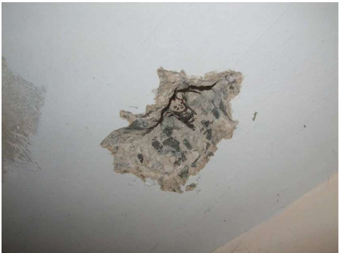
Рисунок 3.20 – Визначення параметрів армування механічним методом шляхом відкриття арматури збірної залізобетонної панелі перекриття 12-го поверху будівлі готелю
