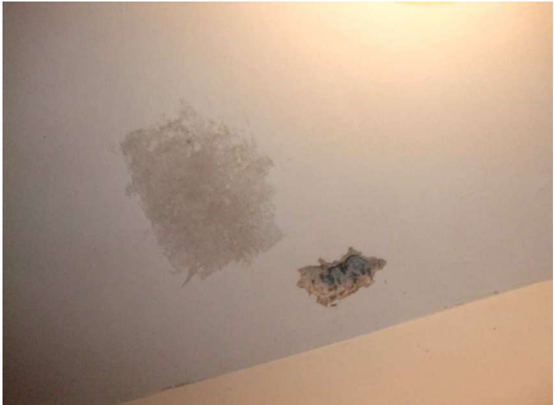
Рисунок 3.19 – Ділянка «П-3» дослідження збірної залізобетонної панелі перекриття 12-го поверху будівлі готелю
