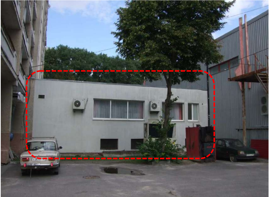
Рисунок 3.3 – Вид з задньої сторони одноповерхової прибудови рецепції будівлі готелю
