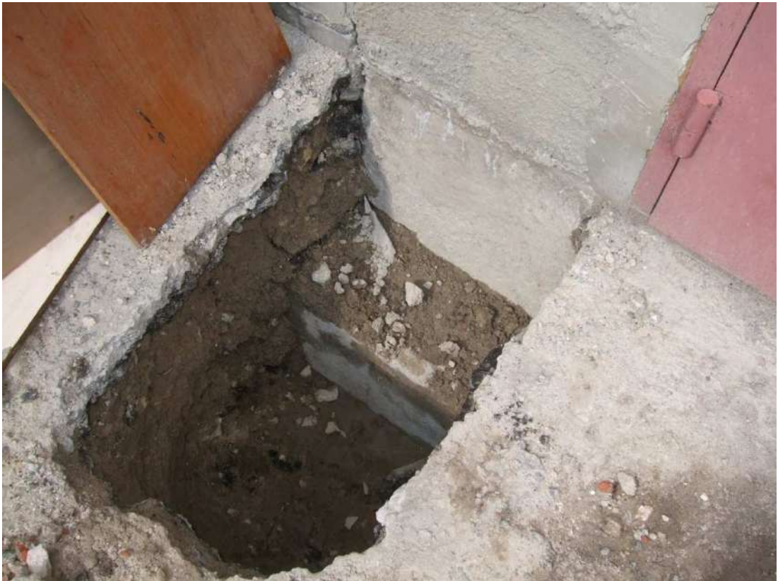
Рисунок 3.5 – Шурф №1 біля фундаменту прибудованої незадимлюваної сходової. Місце дослідження монолітного залізобетонного ростверку
