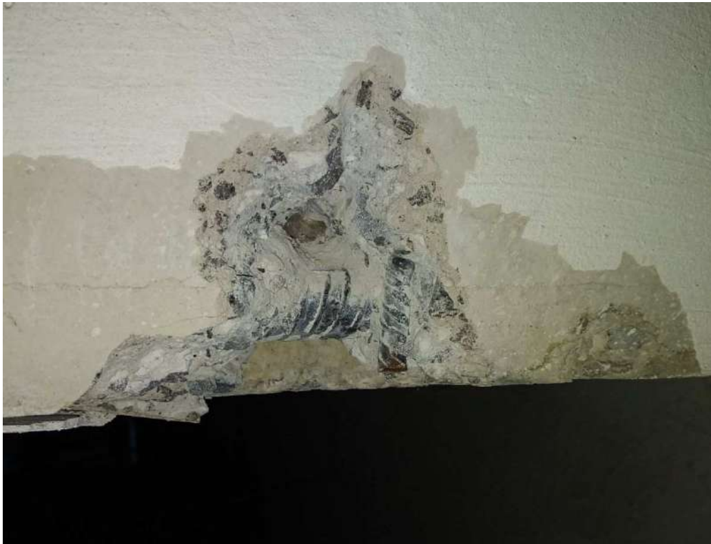
Рисунок 2.12 – Ділянка «2»: Місце визначення діаметру робочої арматури в поздовжньому ребрі плити
