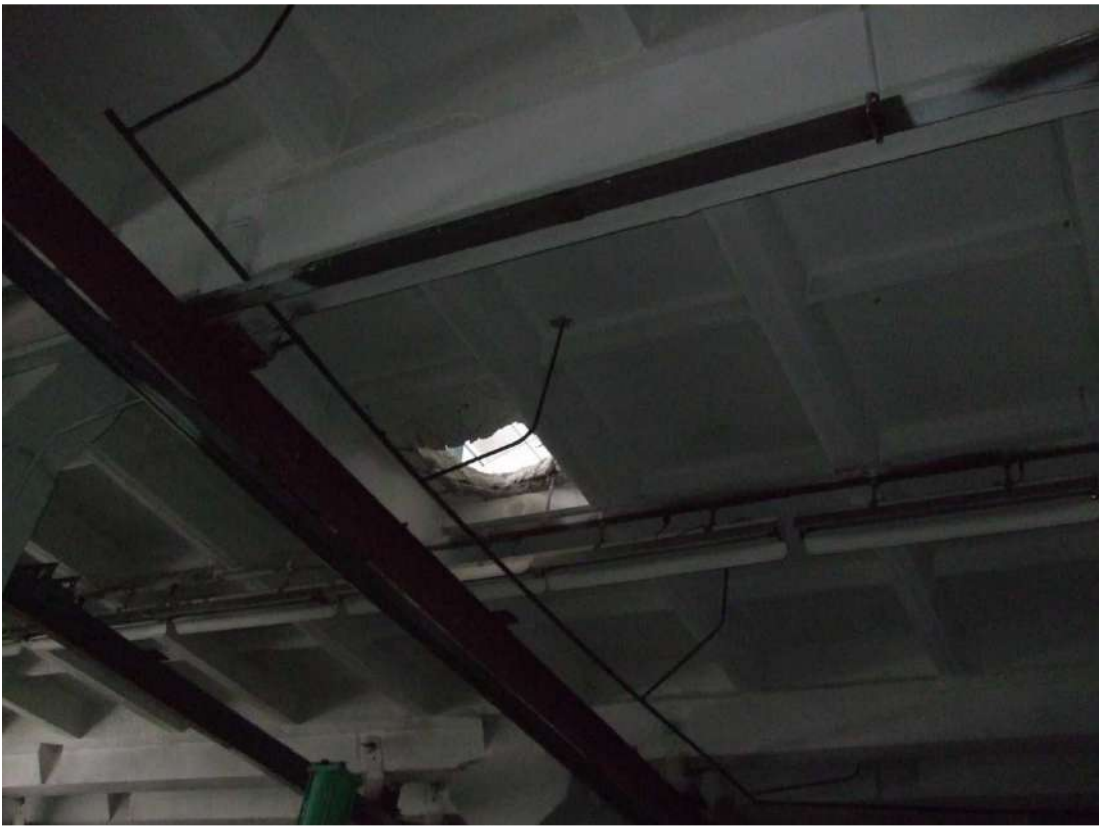
Рисунок 2.7 – Ділянка «1» проведення інструментального обстеження збірних залізобетонних ребристих плит перекриття на відмітці +6,000 м
