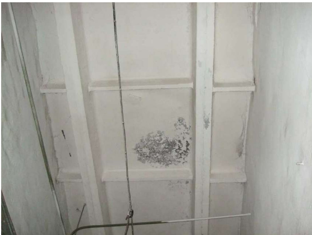
Рисунок 2.9 – Ділянка «3» проведення інструментального обстеження збірних залізобетонних ребристих плит перекриття на відмітці +6,000 м
