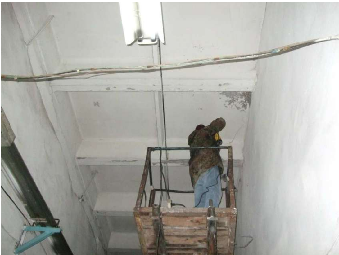
Рисунок 2.8 – Ділянка «2» проведення інструментального обстеження збірних залізобетонних ребристих плит перекриття на відмітці +6,000 м
