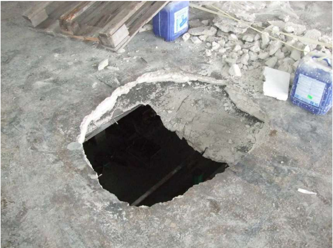
Рисунок 2.10 – Ділянка «1»: Місце на якому відбулось руйнування полиці ребристої плити перекриття в результаті дії зосередженого навантаження
