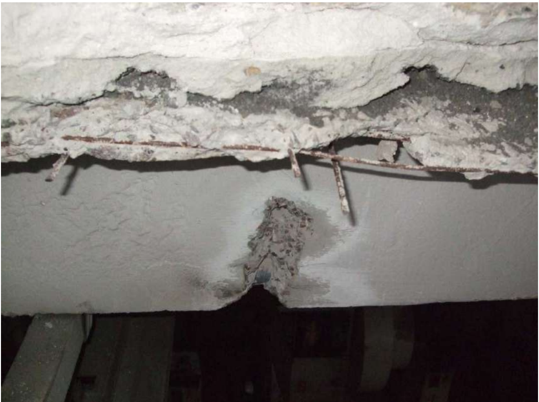
Рисунок 2.11 – Ділянка «1»: Місце визначення діаметру робочої арматури в поздовжньому ребрі плити
