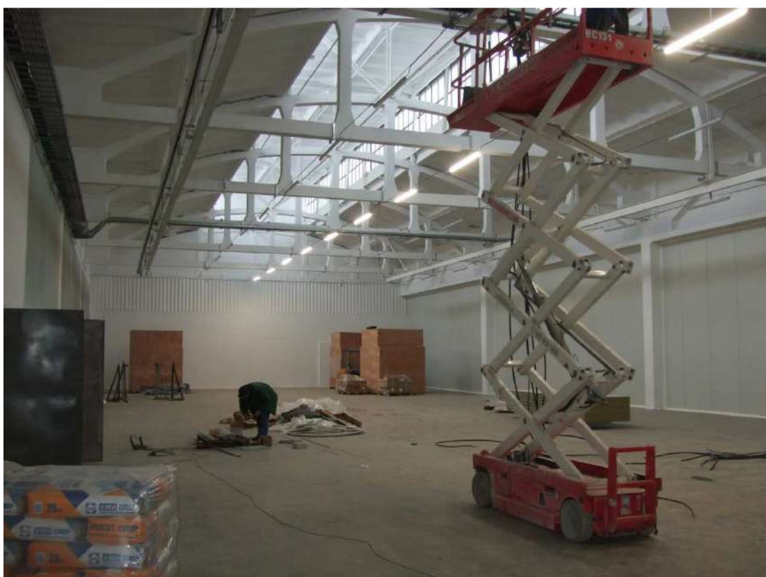
Рисунок 2.5 – Внутрішній простір приміщення в'язального цеху (858,06 м 2 )
