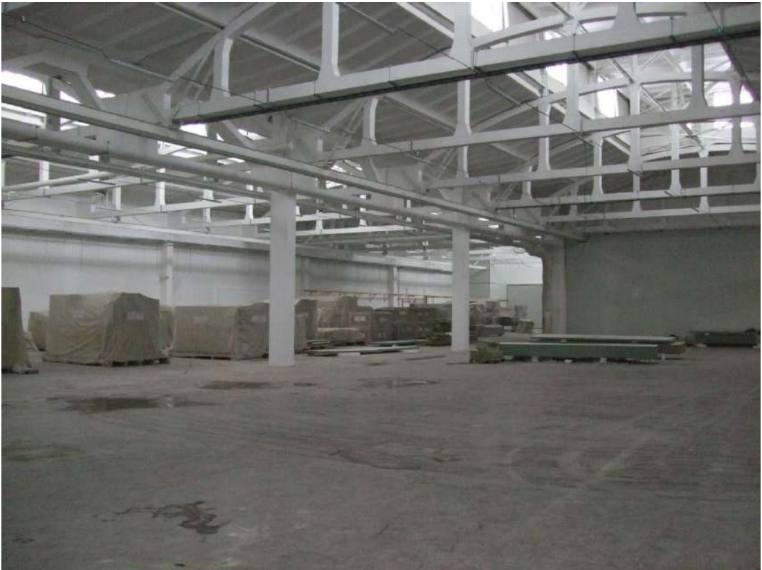
Рисунок 2.6 – Внутрішній простір приміщення цеху термічної обробки (2184,19 м 2 )
