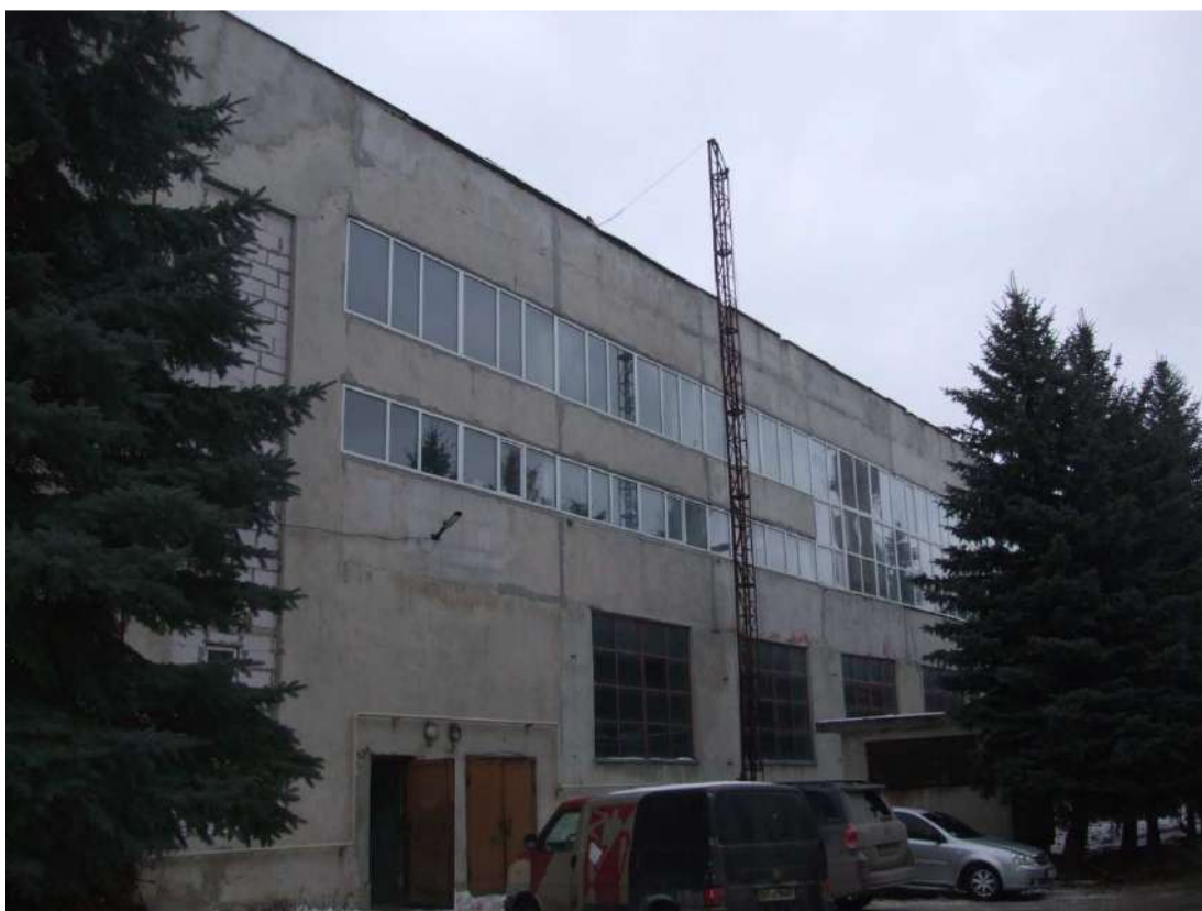
Рисунок 2.3 – Загальний вигляд будівлі приміщення корпусу №1 за адресою: 46023, м. Тернопіль, вул. 15 квітня, 6 (об'єкт нерухомості 190330186101)
