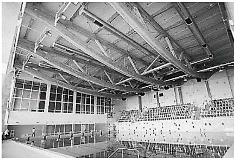
Рисунок 1.2 - Лінзоподібні ферми прольотом 45 м
