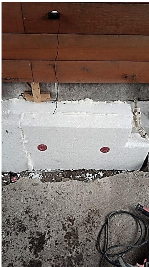
Рисунок 3.2 - фрагмент утеплення стіни технічного підвалу
