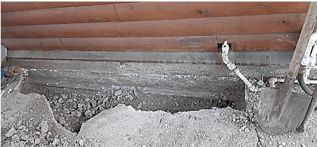
Рисунок 3.1 - фрагмент стіни технічного підвалу перед утепленням
