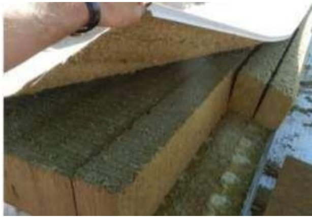
Рисунок 1.16 - Відшарування утеплювача від сталевого листа
