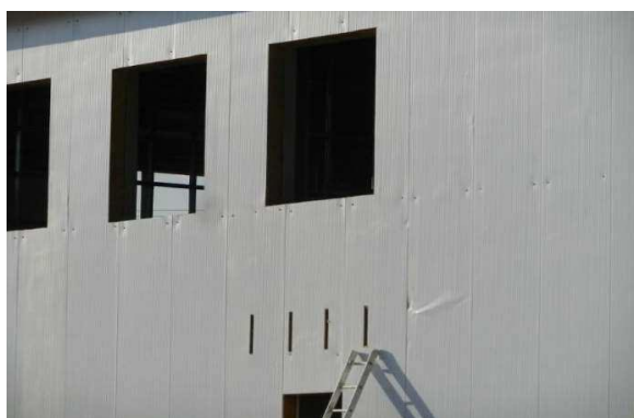
Рисунок 1.19 - Зминання сендвіч-панелей через перетягнуті саморізи
