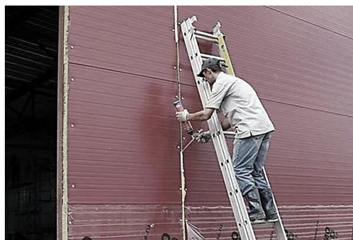
Рисунок 1.14 - Ущільнення монтажною піною стиків сендвіч-панелей
