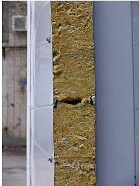
Рисунок 1.25- Утеплювач сумнівної якості
