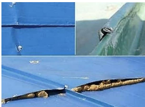
Рисунок 1.18 - Зминання сендвіч-панелей
