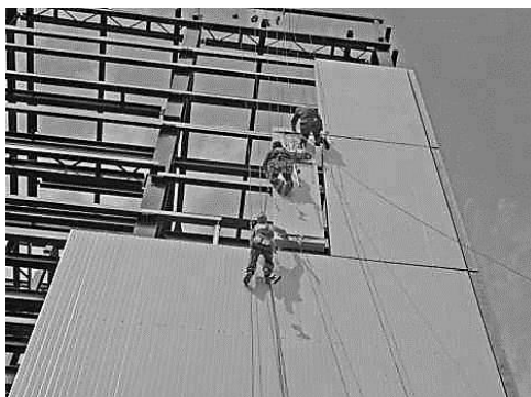
Рисунок 1.12 - Монтаж стінових сендвіч-панелей
