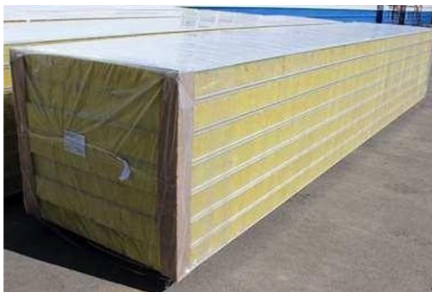
Рисунок 1.23 - Правильне складування панелей на будівельному майданчику
