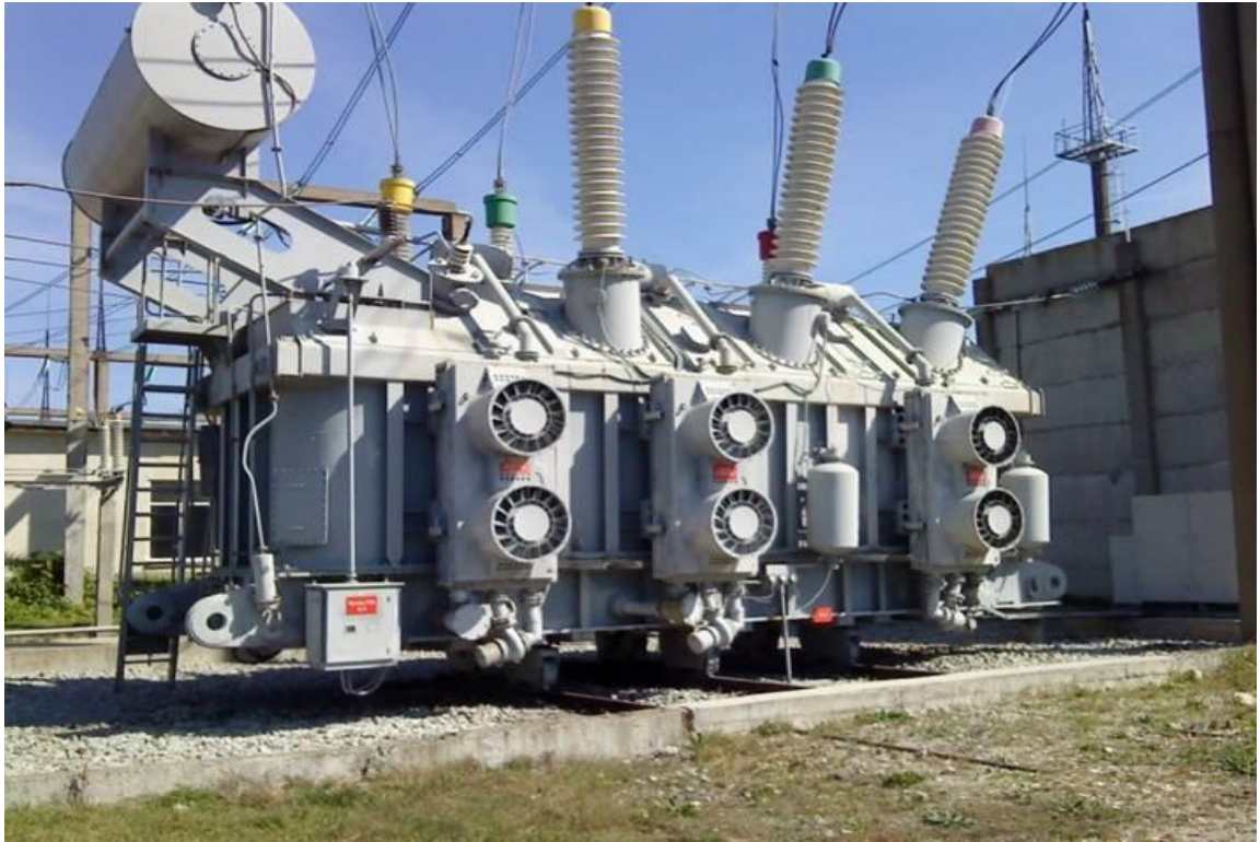
Рис. 1.1. Автотрансформатор
