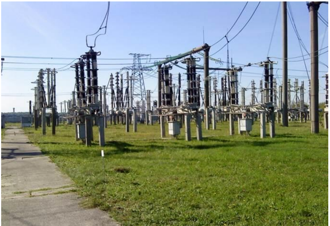
Рис. 1.2. Високовольтний розподільчий пристрій ВРП 330
