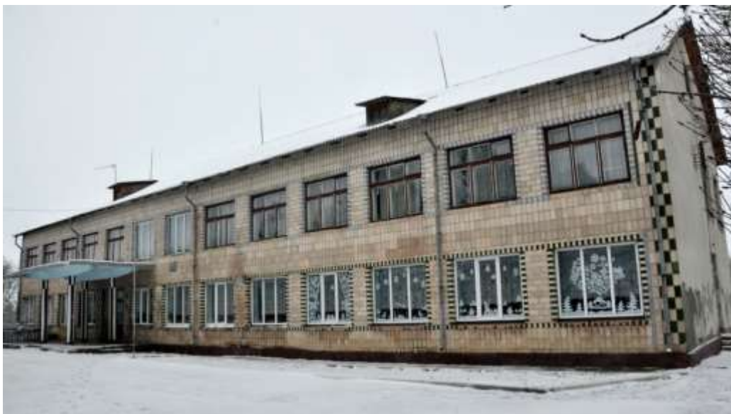
Рисунок 1.1 – Зображення будівлі Початкової школи с. Ромашівка
