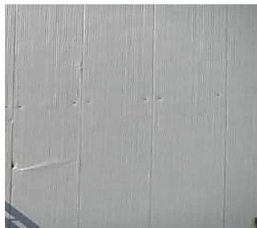
в) зім'яття сендвіч-панелей через перетягнуті саморізи
