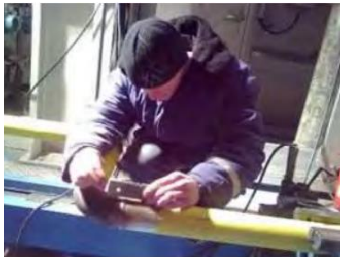
Рисунок 4.5 – Процес візуального контролю зварного з'єднання
