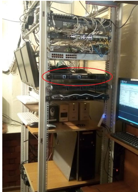
Рис. 2.8. Сервер HP ProLiant DL160 G6 у серверній стійці навчального закладу
