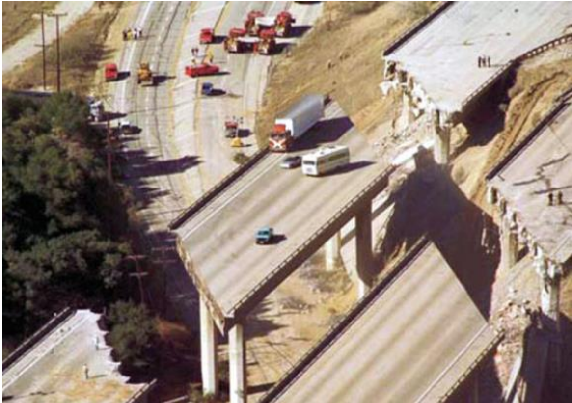
Рисунок 1.1 – Обвалення мосту під час землетрусу [2]
