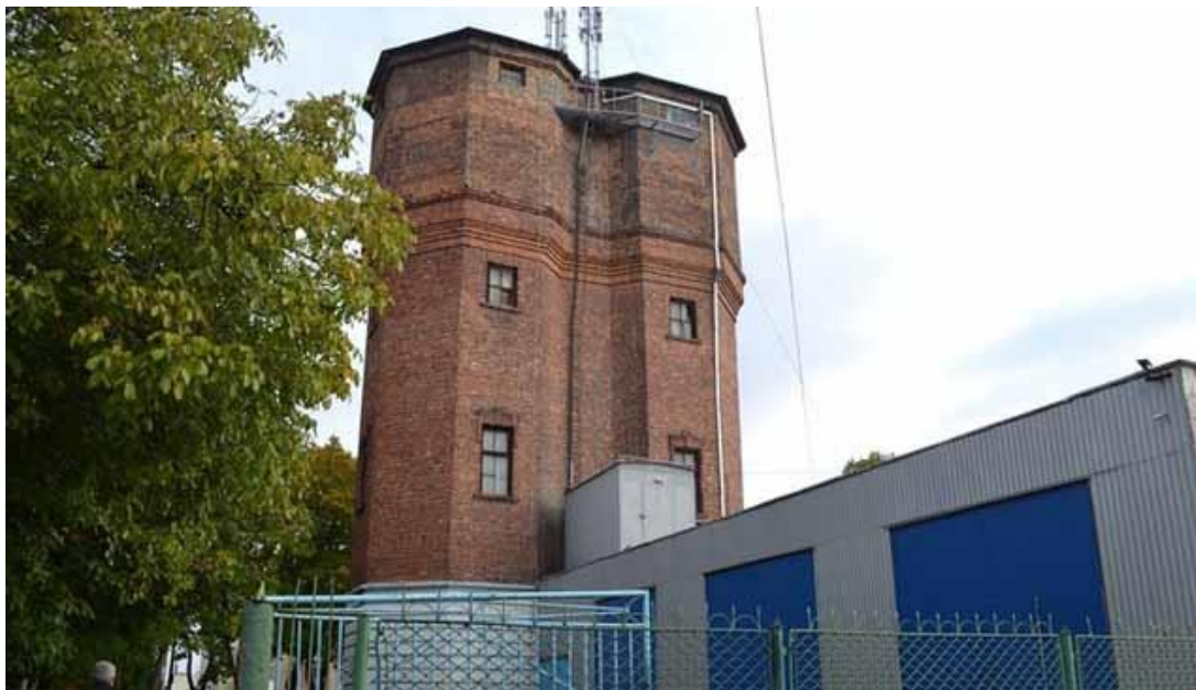
Рисунок 1.1 – Загальний вигляд будівлі водоканалу (збудована у 1956 році).
