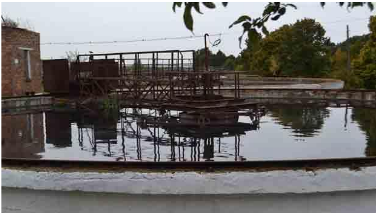
Рисунок 1.4 – Очисні споруди КП «Новоовлинськводоканал».
