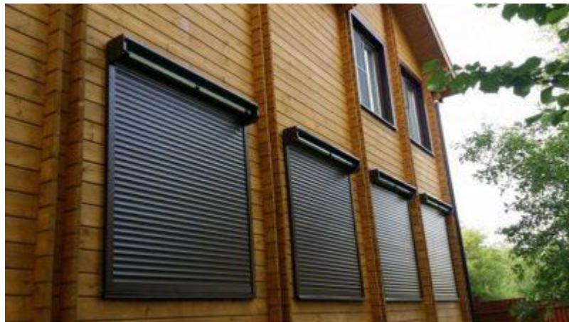
Рисунок 1.1 – Встановлення ролетів у будинку
