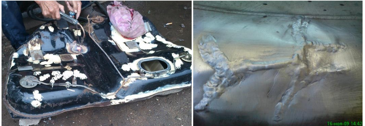
Рисунок 2.10 - Ремонт бака зваркою
