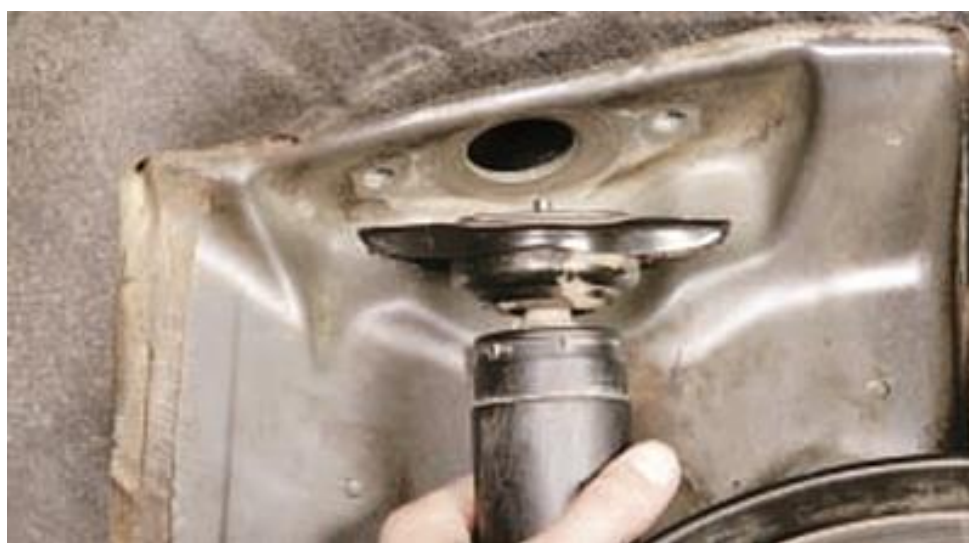
Рисунок 2.6 – Демонтаж амортизатора в зборі з опорою
