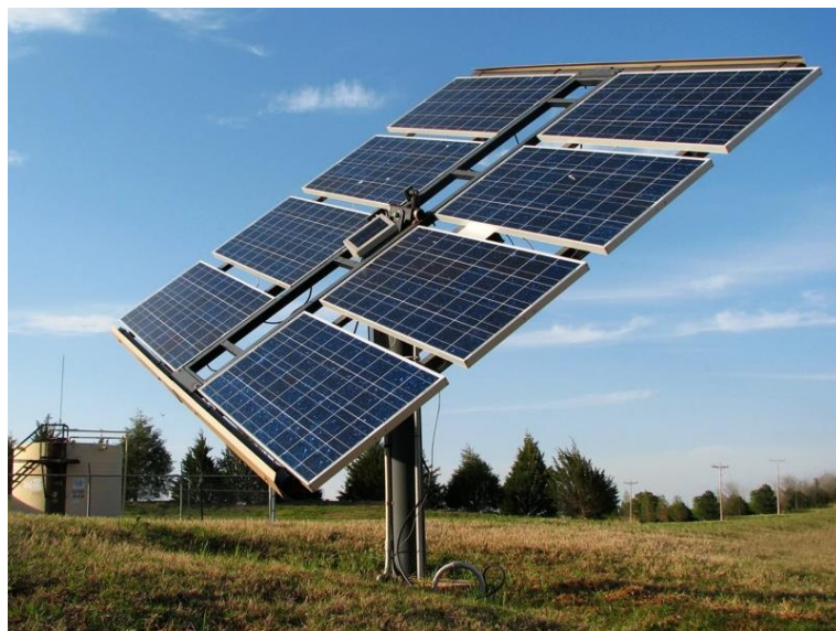
Рисунок 1.1 - Фотоелектричні системи змонтовані на дах (а) і вільно-стоячі із сонячним трекером
