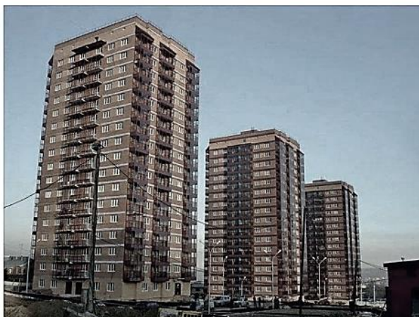
Рисунок 1.5 – Вигляд готової будівлі, що зводився за вдосконаленою технологією «Saret»
