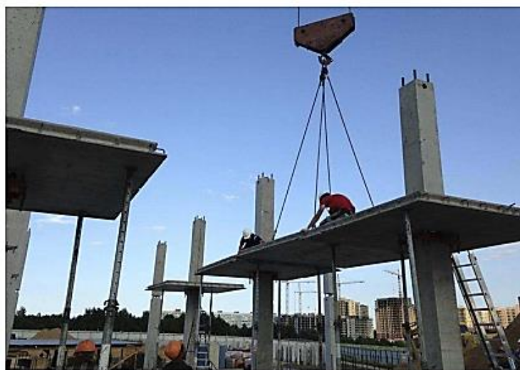
Рисунок 1.6 – Процес монтажу навісних плит перекриття збірно – монолітного каркасу
