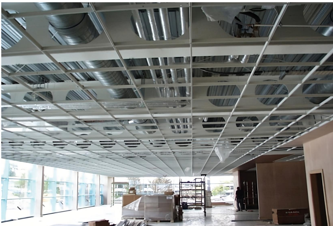
Рисунок 1.4 – Проведення комунікацій через отвори в стінці балки [2]
