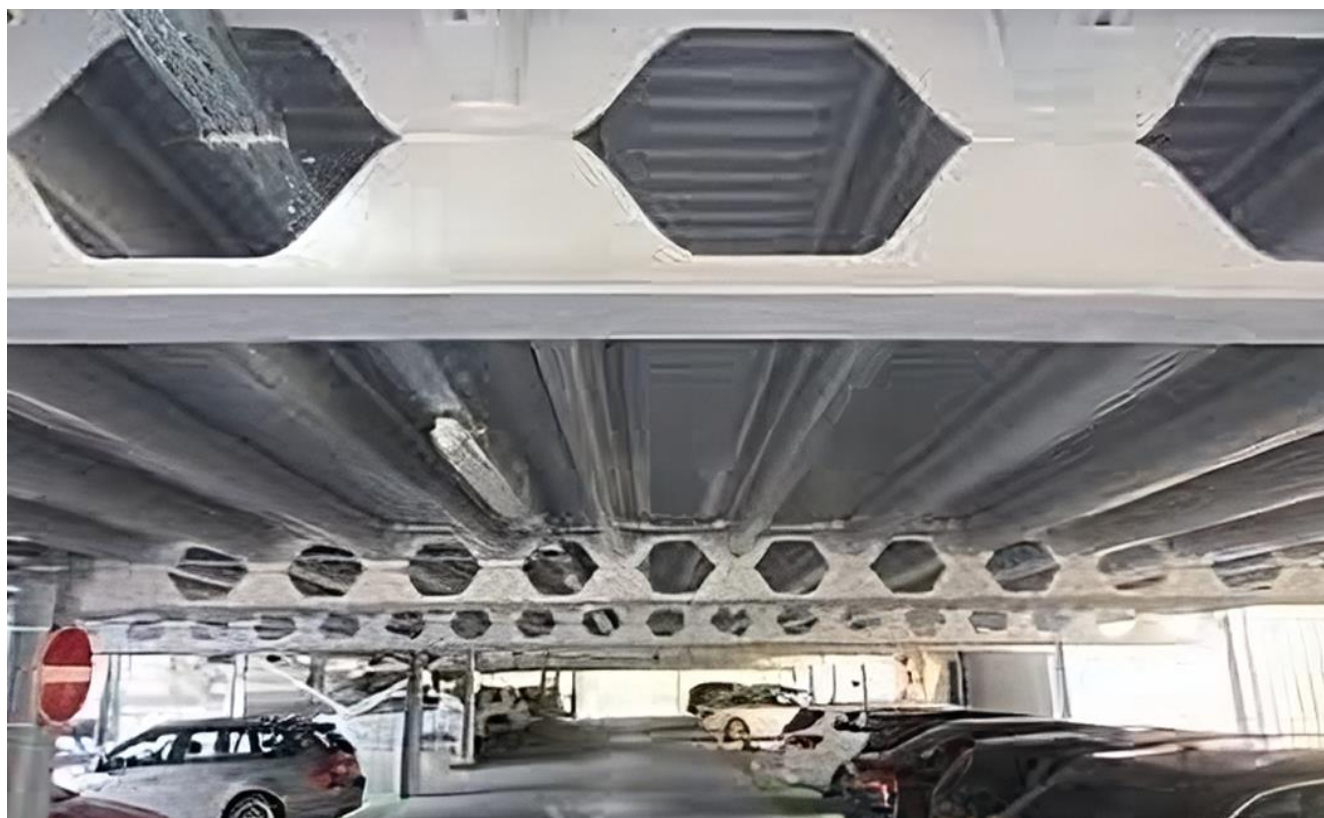
Рисунок 1.5 – Застосування перфорованих сталевих балок в багаторівневих паркінгах [10]
