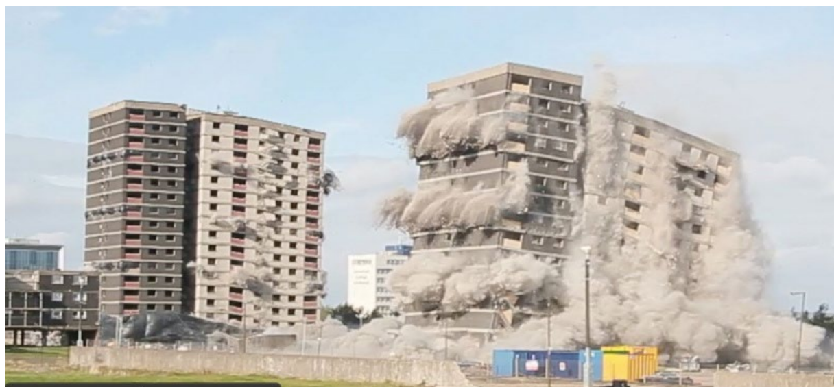
Рисунок 1.12 – Руйнування будівлі вибуховим методом [22]
