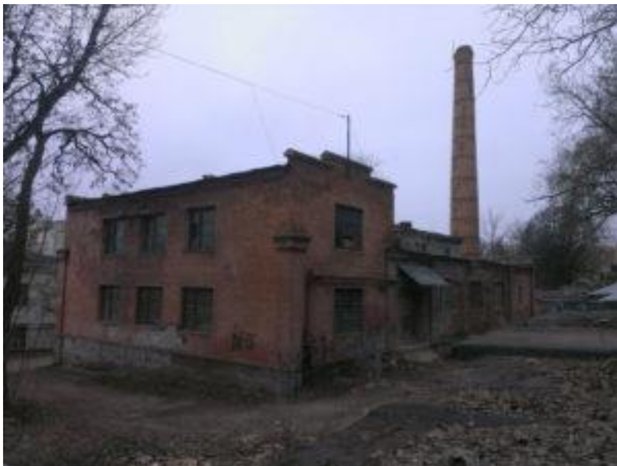
Рисунок 3.1 – Котельня по вул. Багата
