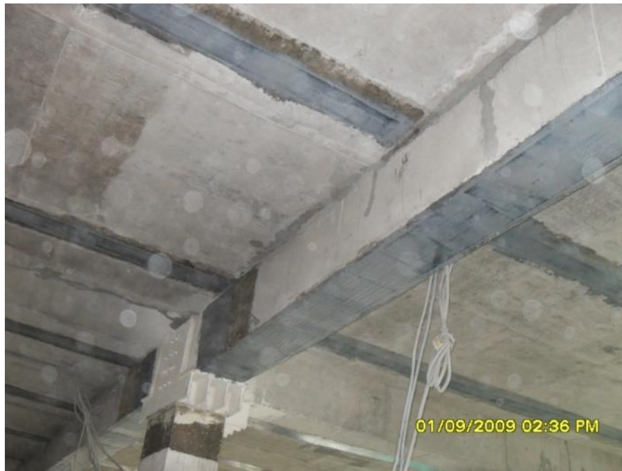
Рисунок 3.11- Підсилення балок за допомогою вуглепластиків
