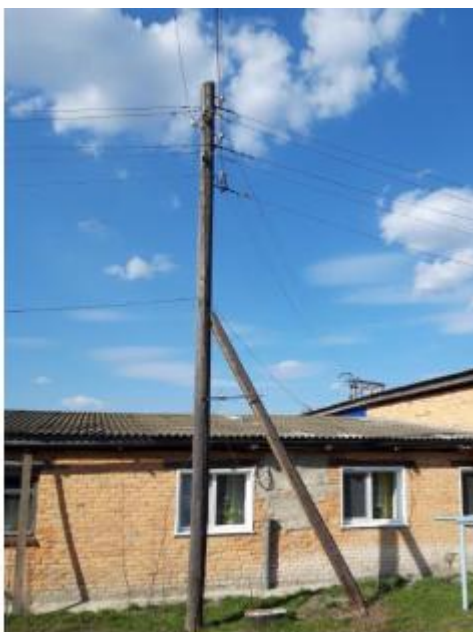
Рисунок 2.32 – Відпайка ПЛ-0,4 кВ у будівлю «Гараж».
