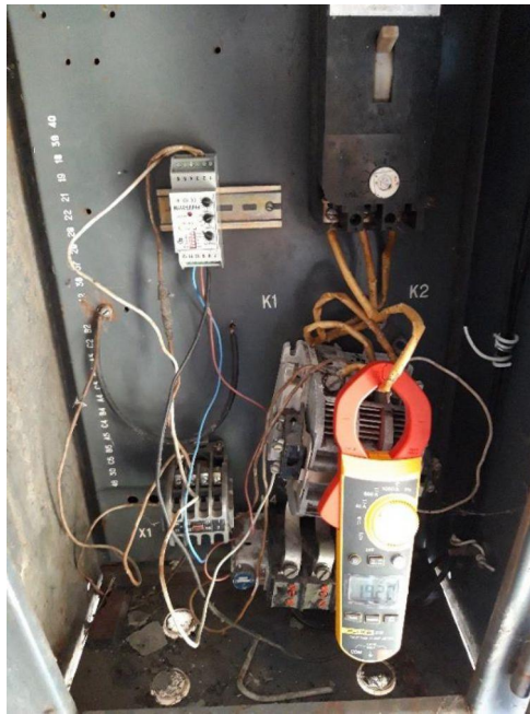
Рисунок 2.29 – Проведення вимірювань приладом FLUKE 319 струмових навантажень у фазному проводі L1 насоса «Глибинний верх №2»
