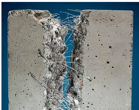
А) Хаотичне армування залізобетону
