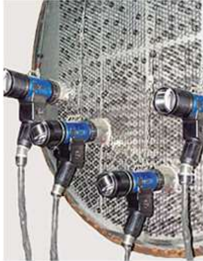
Рисунок 2.17- Зварювання труб з трубною решіткою
