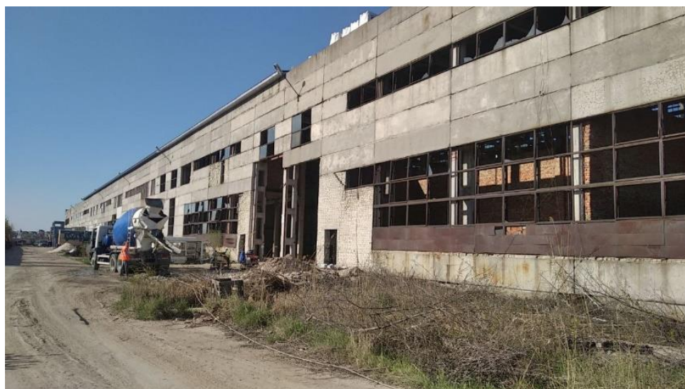
Рисунок 1.2 – Фасад споруди до реконструкції
