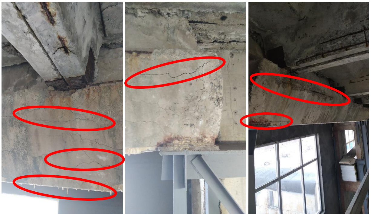
Рисунок 1.7 – Візуальний огляд залізобетонної балки:
