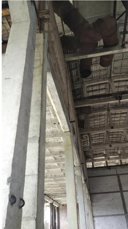
Рисунок 1.11 – Фотографія колон, балок, стін до реконструкції під адмінприміщення
