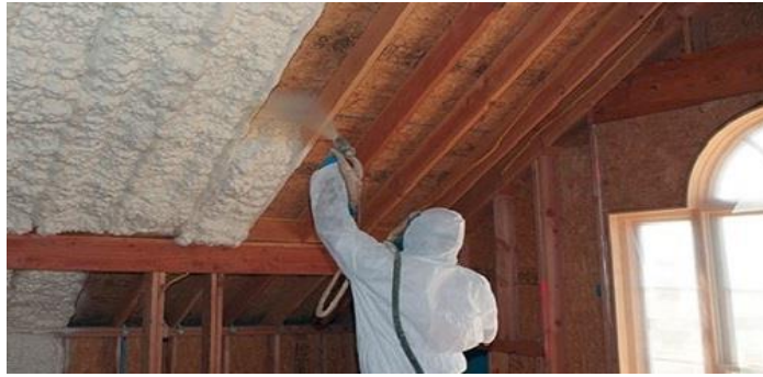
Рис. 15 Процес напилення шару ППУ
