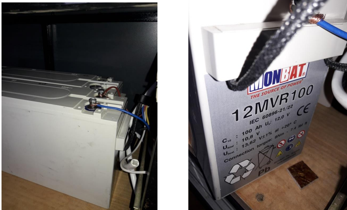
Рисунок 3.10 – Акумуляторна батарея MONBAT 12MVR100 (12В, 100 А·год)
