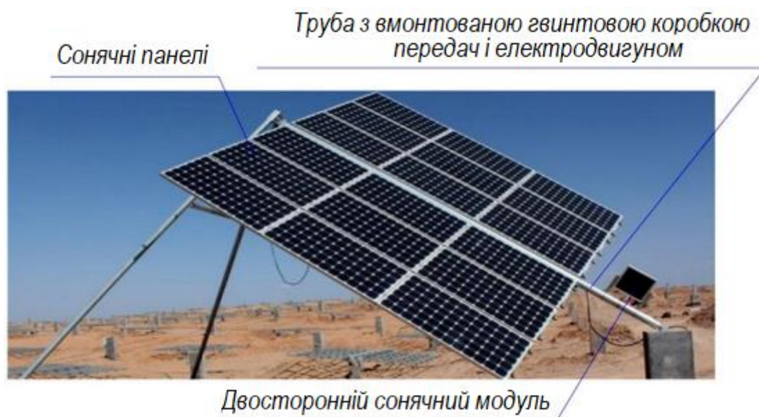
Рисунок 1.15 – Сонячна установка Traxle зі слідкуючою системою
