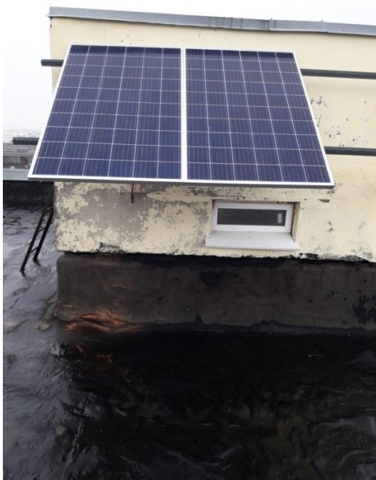
Рисунок 3.7 – Сонячні панелі Photovoltaic JKM280PP-60-V
