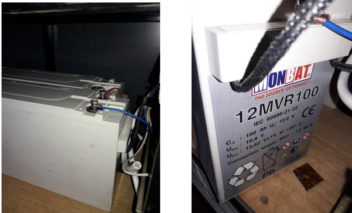
Рисунок 3.10 – Акумуляторна батарея MONBAT 12MVR100 (12В, 100 А·год)
