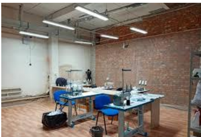
Рисунок 1.1 – Система загального рівномірного освітлення робочих місць швейного виробництва
