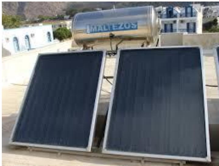
Рис. 1.1. Плоский сонячний колектор
