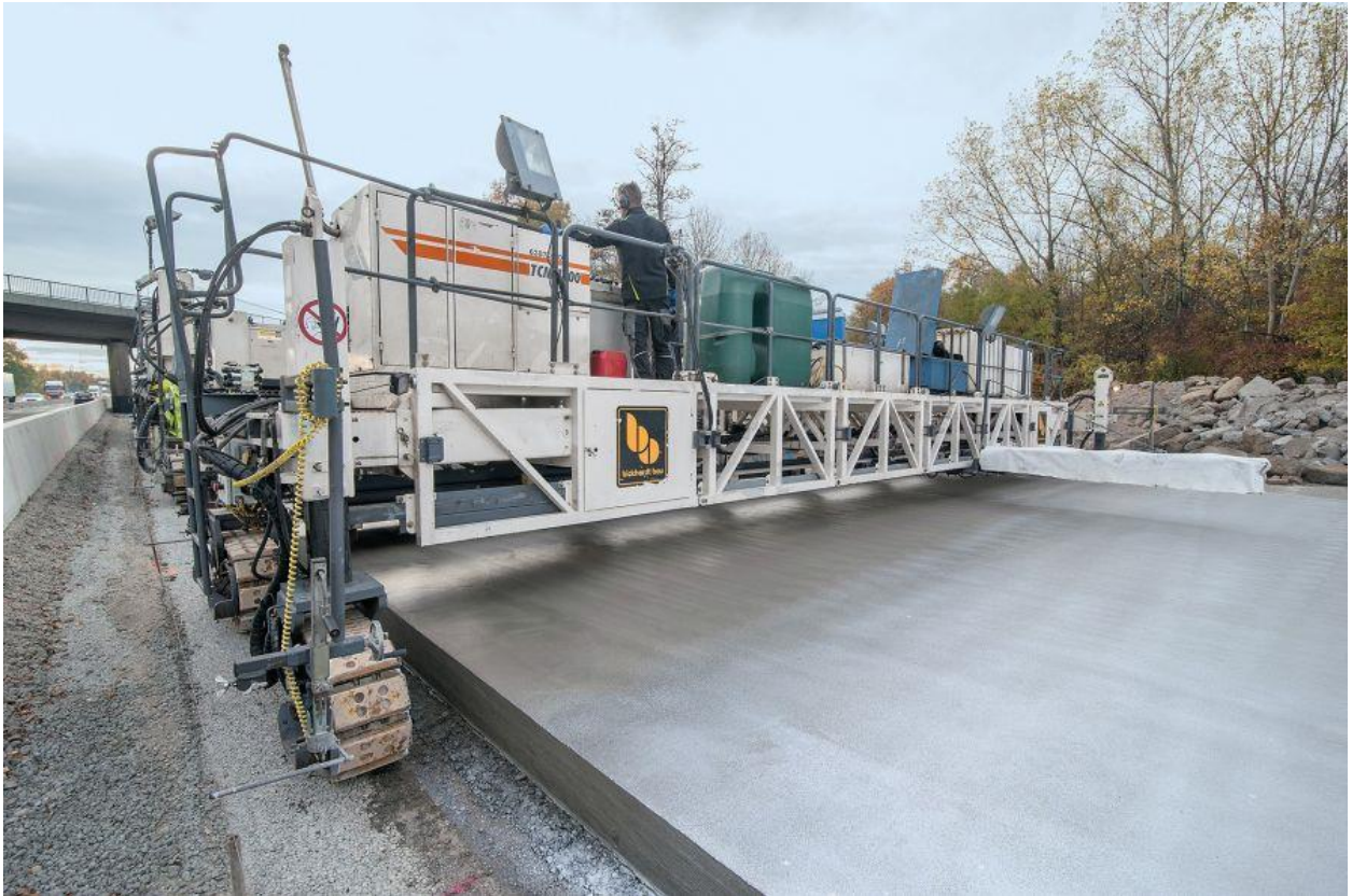
Рис. 3.2. Приклад укладання дорожнього покриття з використанням німецьких технологій
