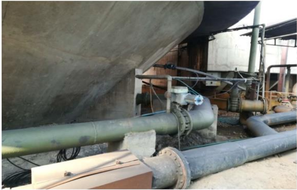
Рисунок 1.3 - Нижня частина освітлювача та вхідного клапана освітлювача.
