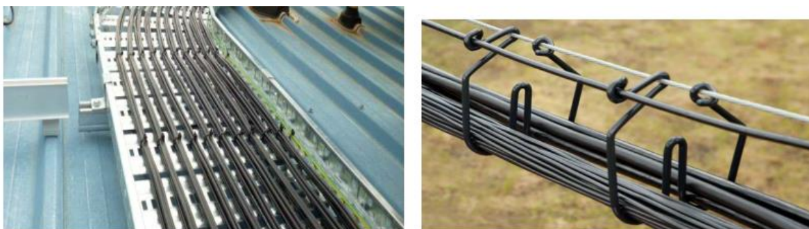
Рис. 3.6 – Прокладання кабелів в лотках та за допомогою стяжок.
