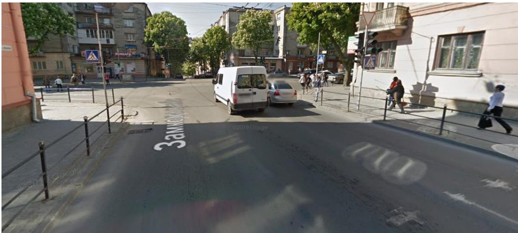
Рис. 1.8. Стан дорожнього полотна на вул. Замкова у напрямку до вул. Руська
