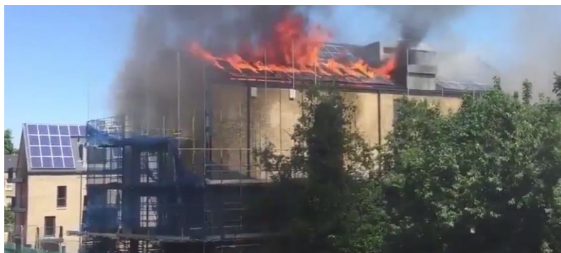
Рис. 4.3. Пожежа на даху будинку з сонячними панелями
